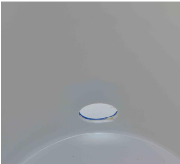
A: Skruva bort den gamla kranen
